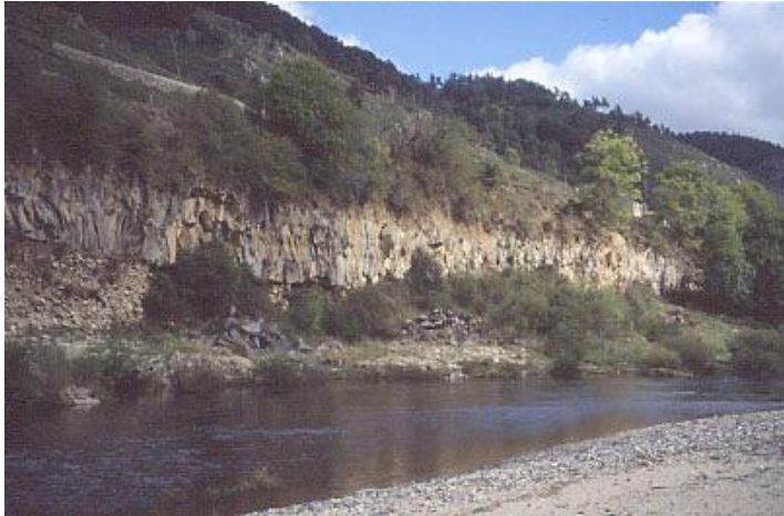
Erosion amont de Goudet
